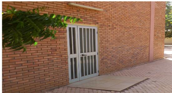
Figure 3: BTC utilisé en double peau
